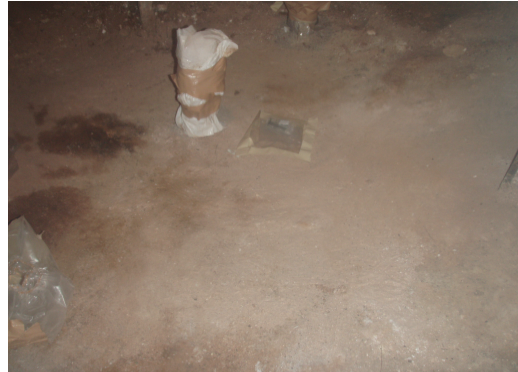
スラッジ回収及び除染後
