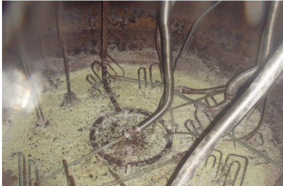
スラッジ回収前
